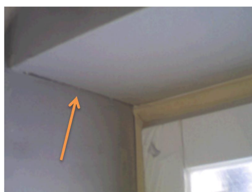
9 och 10 Luftläckage i övre hörnet i fönstersmygen. Bilden tagen med värmekamera visar hur sval luft strömmar in och kyler ytorna kring hålet.
