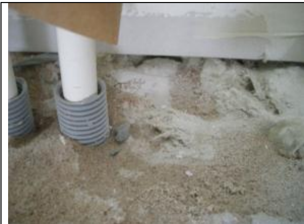
Bild 5 och 6 luftläckage i golvvinkeln i mötet mellan golvet och väggelementet. Den här typen av läckage är vanligast i anslutning till balkongen där det finns ett utfackningsparti..
