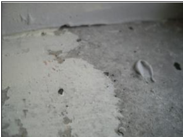
Bild 11 och 12 Luftläckage genom springa i betongen i fönstersmygen.
