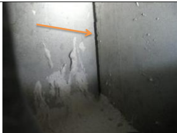
Bild 11 och 12 Luftläckage genom springa i betongen i fönstersmygen.
