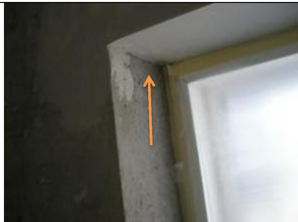
Bild 11 och 12 Luftläckage genom springa i betongen i fönstersmygen.
