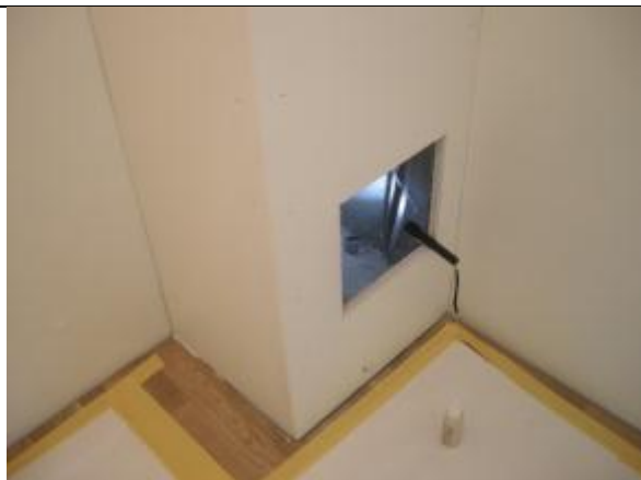
Bild 13 och 14 Luftläckage i schakt i glipa mellan betongelement.
