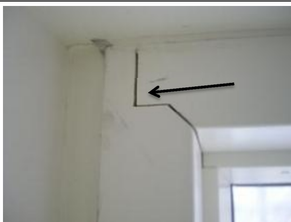
Bild 15 och 16 visar möten mellan olika delar i dörr och fönsterkarmar där det ofta förekommer luftläckage
