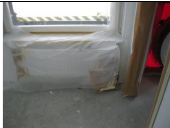
Bild 5 och 6 luftläckage i golvvinkeln i mötet mellan golvet och väggelementet. Den här typen av läckage är vanligast i anslutning till balkongen där det finns ett utfackningsparti..
